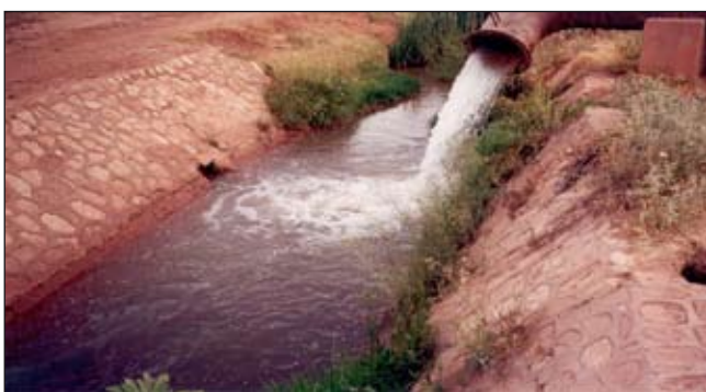
Photo 2 : Rejet des unités industrielles dans les eaux de surface.
